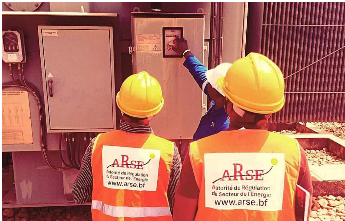
Visite des installations techniques dans le cadre du contrôle des activités des opérateurs
